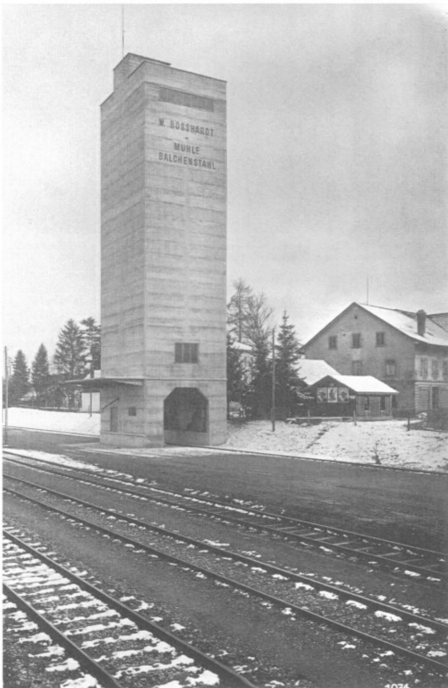
Die weithin sichtbare Visitenkarte am Bahnhof Pfäffikon: Der 1935 errichtete markante Siloturm aus Sichtbeton dient bis heute als Getreidelager.
