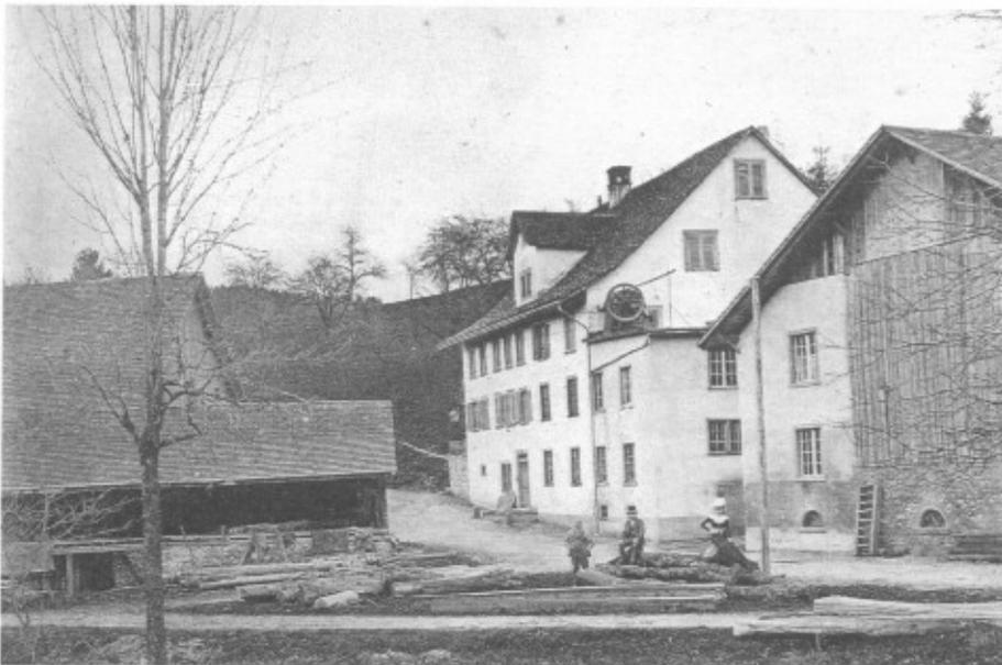
Balchenstahl an der Schwelle zur Moderne: links die Sägerei, rechts das stolze Mühlengebäude. Auf dem Dach des Anbaus, in dem sich früher das Wasserrad befand und heute die Turbine weiterhin in Betrieb ist, erkennt man ein Transmissionsrad, das bis 1891 Mühle und Nebenbetriebe mit Energie versorgte.
